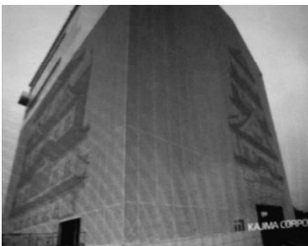
城の持ち主ですが、羽柴秀吉、池田輝政、本多忠輔、松平家と瓦の家紋に変化が見られます。壁のコマイはここは竹でなく木を使っています。壁土は土に藁をまぜますが、腐らせて粘りけをだし、海藻を煮てまぜます。しかし、城では火気厳禁で困りました。どうやら電気釜の使用許可が出て、それを使用しました。―― 見学者通路や内部の説明、しゃち瓦、土壁、砂漆喰、仕上げの漆喰などの話、端の窓は耐震様に締め切り、盗難や火災の TV カメラが市役所に直結、漆喰の料は 2 年で 250 トンなど―― 多くのお話がありました。
